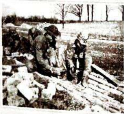
Строительство дороги в США. 1933 г.
